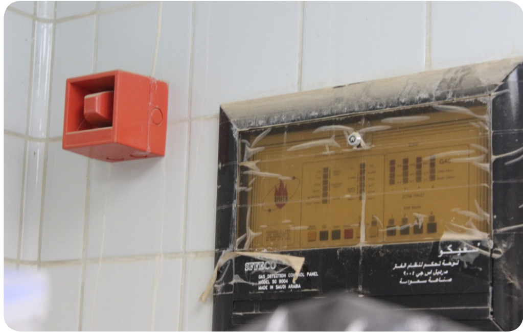
صورة توضح لوحة التحكم بإنذار الحريق الجديدة مقارنةً بلوحات التحكم قبل تنفيذ المشروع
