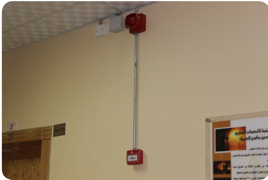
صورة توضح نقاط الإنذار اليدوية (MCP) الجديدة مقارنة بنقاط الإنذار قبل تنفيذ المشروع.
