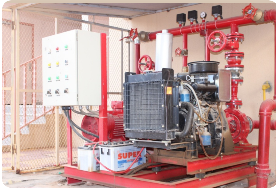
صورة لمضخة الحريق المزودة (كهرباء وديزل) والتي تعمل في حال انقطاع الكهرباء
