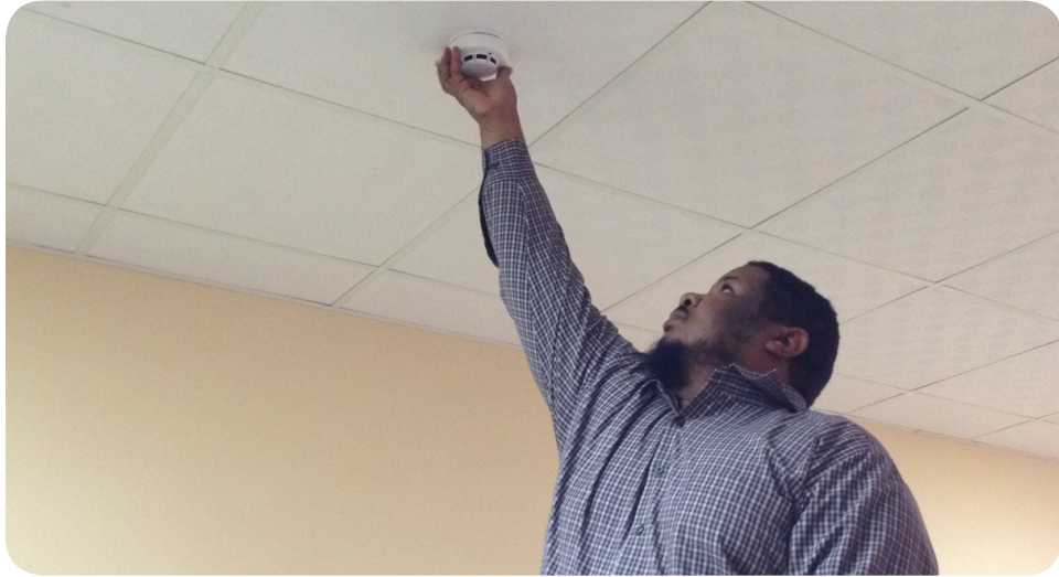
صور توضح عملية التركيب لوسائل الإنذار بأحد الكليات.
