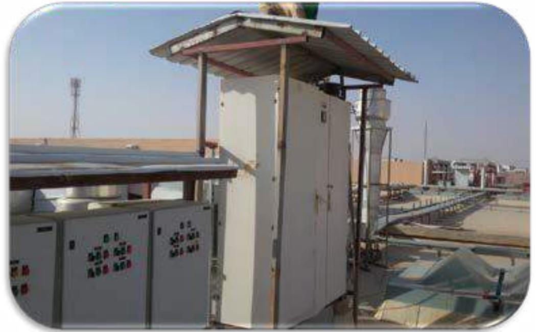
عمل ١٥ مظلة لتغطيه لوحات الكهرباء الموجودة في السطح لحمايتها من الامطار
